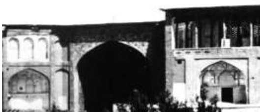
تصویر ۹. قاب‌بندی و روزن‌های آجری در بدنه شمالی نقاره‌خانه. (هولستر، ۱۹۷۵: ۱۵۲)
