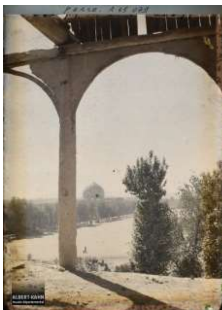
تصویر ۱۶. اضافه شدن قوس‌های نیم‌دایره‌ای و حذف سرستون‌ها (۱۳۰۷-۱۳۰۴ ه.ش). (آرشیو سازمان میراث فرهنگی، گردشگری و صنایع دستی اصفهان، ۱۳۹۸)
