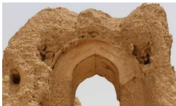
شکل ۱۶: استفاده از گچ در طاق‌ها در ایوانچه‌های فضای شاه‌نشین
