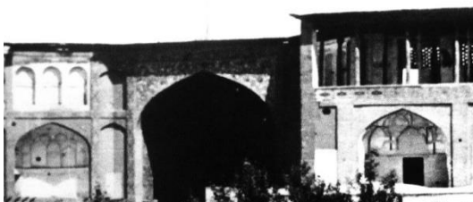
تصویر ۹. قاب‌بندی و روزن‌های آجری در بندۀ شمالی نقاره‌خانه. (هولستر، ۱۹۷۵: ۱۵۲)
