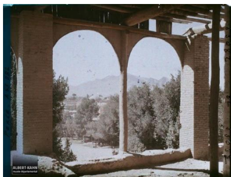
تصویر ۱۵. اضافه شدن قوس‌های نیم‌دایره‌ای و حذف سرستون‌ها (۱۳۰۷-۱۳۰۴ ه.ش). (آرشیو سازمان میراث فرهنگی، گردشگری و صنایع دستی اصفهان، ۱۳۹۸)
